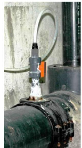
A questo scopo è importante che il montaggio venga realizzato in modo da dotare l'iniettore di una **valvola di intercettazione che consenta di interrompere il flusso dell'acqua** contenuta nella tubazione principale per consentire le operazioni di manutenzione.
